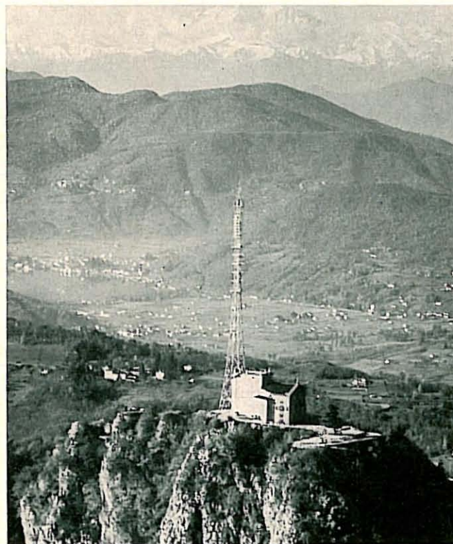
Bild 1: Berggipfel San Salvatore mit Meßturm 1 (PTT), Kirche (Photoraum) und Meß- und Wohngebäude.
