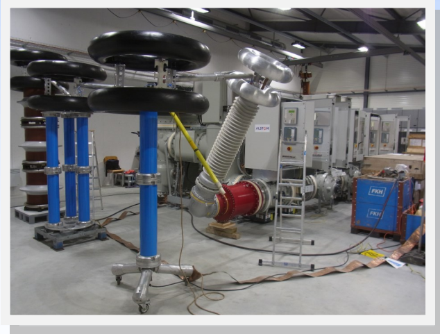
GIS-Prüfungsaufbau an einer 123-kV-Anlage
