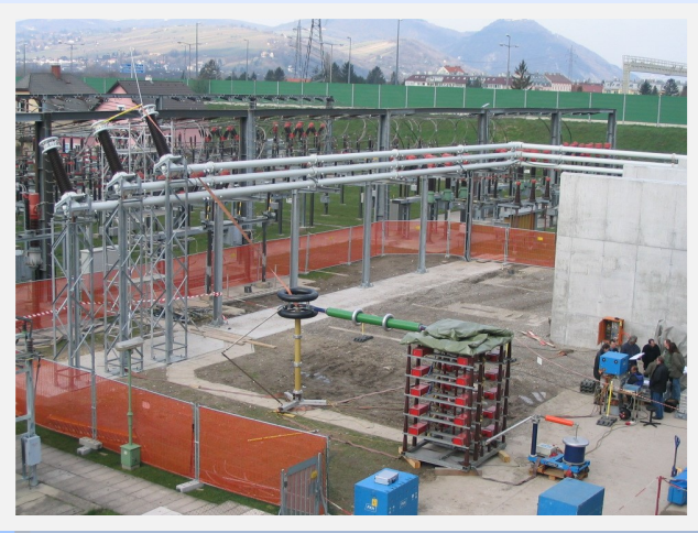
Prüfung an einer 123-kV-GIS mit schwingendem Blitzstoss
