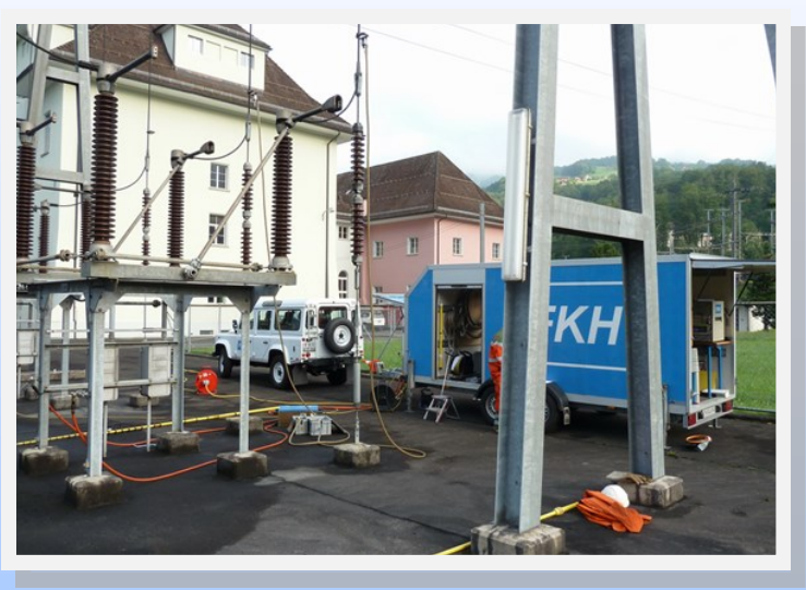
Erdungsmessanlage: Einspeisung eines Prüf-Erdschlussstromes in eine Freileitung im Unterwerk
