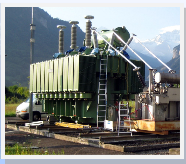
Erregung eines Netzkuppeltransformators für die Teilladungsmessung im Unterwerk
