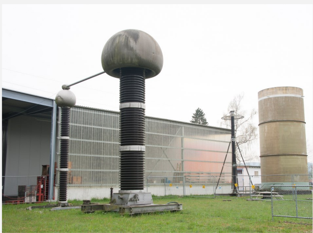
1000-kV-Prüftransformator in der Versuchsstation Däniken
