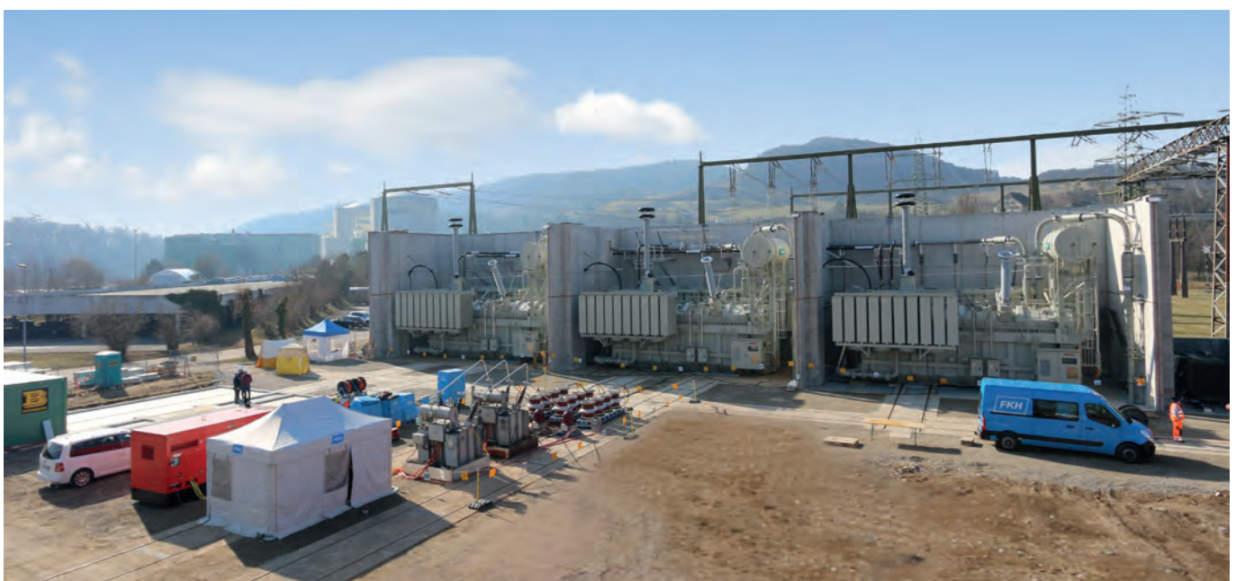
Abbildung 1: UW Beznau, im Vordergrund: Prüfquelle, im Hintergrund: drei Transformatorpole
