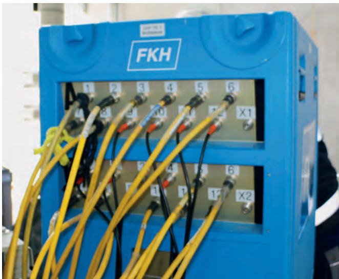
Abbildung 2: Verkabelung der Teilentladungsmesskanäle
