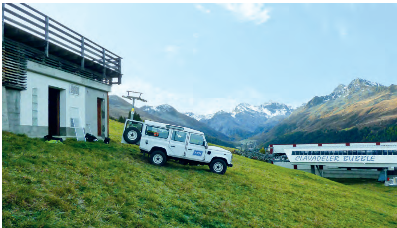
Abbildung 2: Messungen bei der Trafostation Clavadeleralp des EWD
