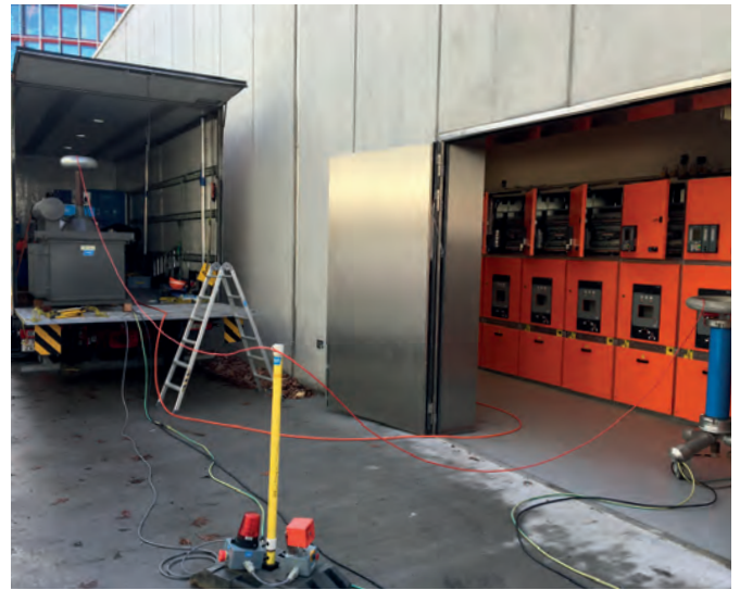
Abbildung 4: Prüfung der MS-Schaltanlage im UW Stand
