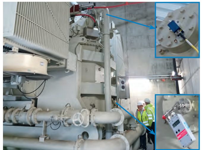
Abbildung 3: Reservepol im UW Lavorgo der Swissgrid, angeschlossener UHF-Vorverstärker (oben rechts), Pulsgenerator für die Durchkopplungsversuche (unten rechts)
