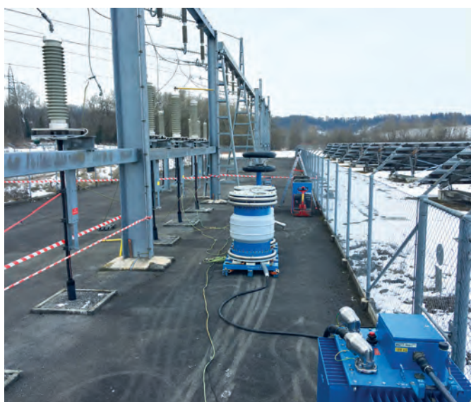
Abbildung 1: Kabelprüfung im UW Verbois
