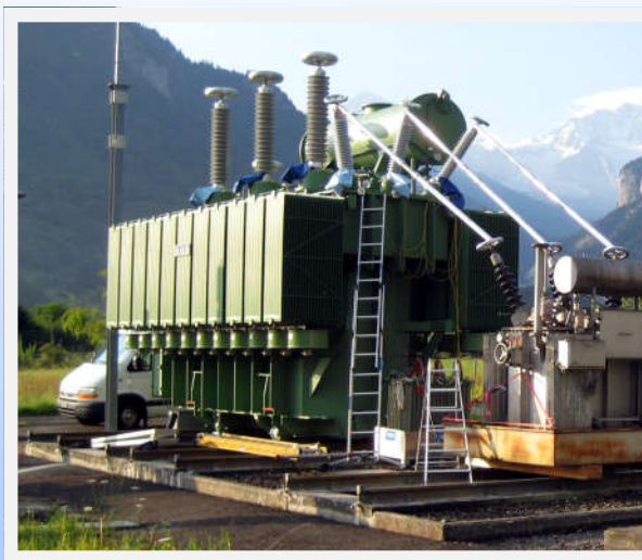
Erregung eines Netz-kuppeltransformators für die Teilentladungsmessung im Unterwerk
